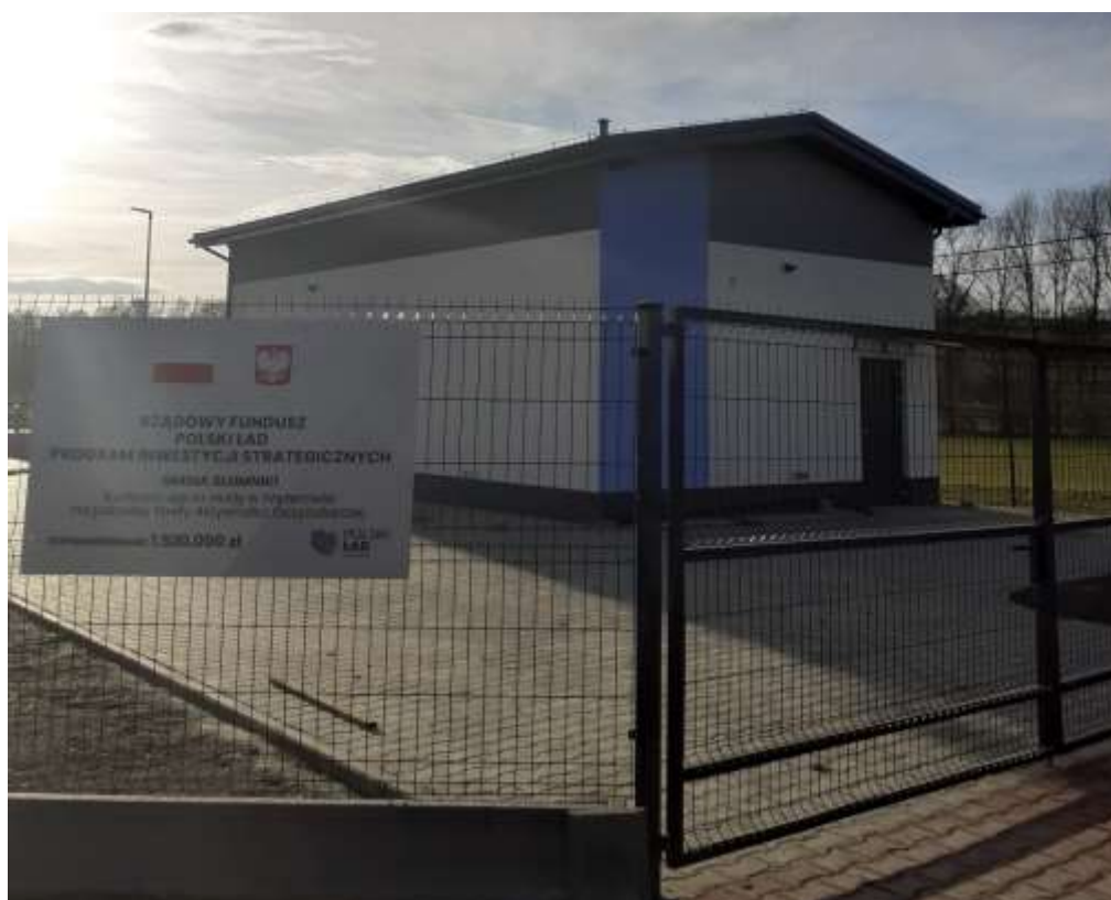
Fot. 2. Nowe ujęcie wody w Wężerowie
